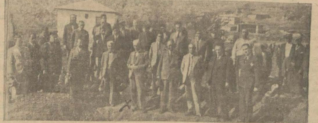
Marashta tren yolu üzerinde bulunan Eloğlu köyünde beş sınıflı ve 50 yataklı, pansiyonlu bir ilköğretim binasının temel merasimle atılmıştır. İlk temel taşı vali koymuş, başöğretmen Ruhî, köy mektebi hakkında bir nutuk söylemiştir. Bundan sonra, merasimde bulunanlara şeker ikram edilmiştir.
